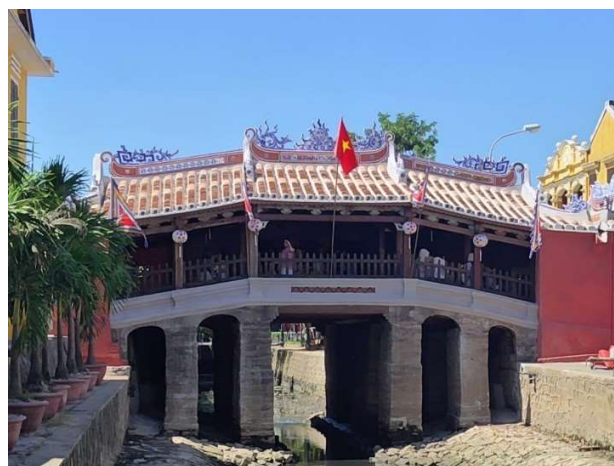
修復されたホイアン日本橋の全景
